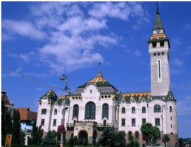
Fig. 5. Fosta primărie , 1907-1908, arh. Jakab Dezső și Komor Marcell.
